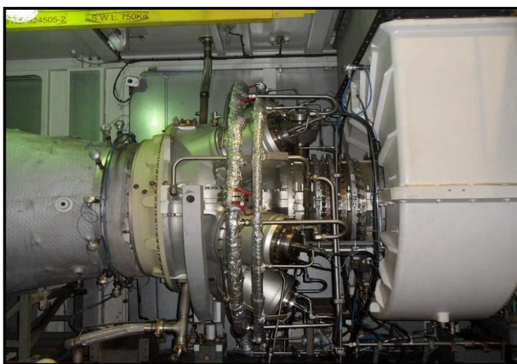
Рис.2. Элементы газотурбинной установки SGT 300 Tempest
